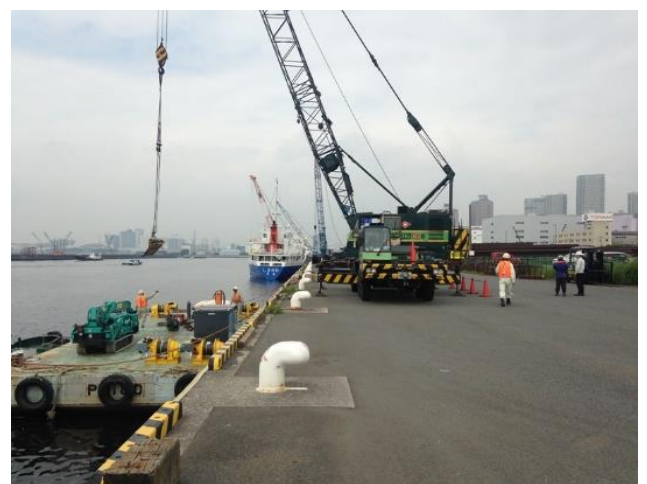
B野積場から船側(港湾荷役)
