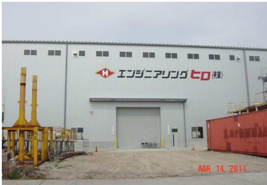
南側搬出入口(外より)
