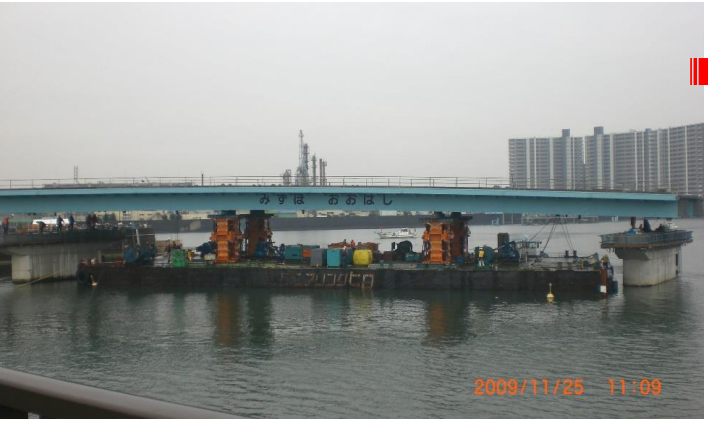
11/25 11:09 橋脚間へ引き込み完了
