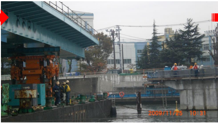
11/25 12:29 橋脚間で微調整 操船ジャッキダウン完了
