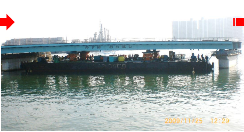
11/25 12:29 橋脚間で微調整 操船ジャッキダウン完了
